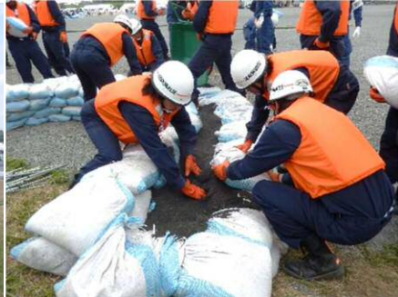
水防団による漏水防止工法の実施状況
