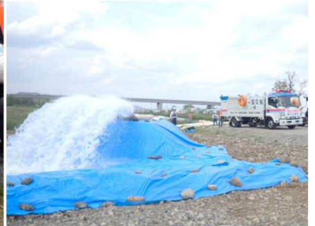
排水ポンプ車による排水訓練状況
