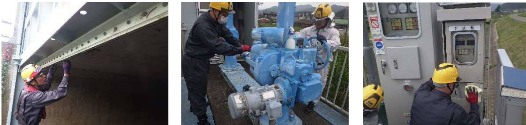
昨年度の樋管点検状況
