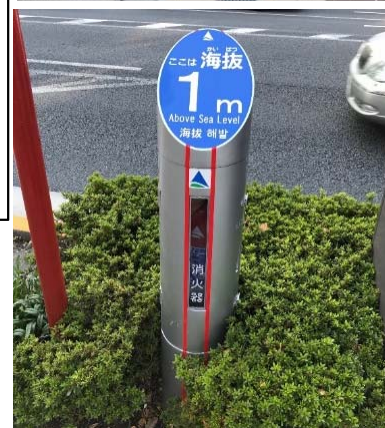
ロケット型消火器格納箱への海拔表示ステッカーを貼付 (足立区)
