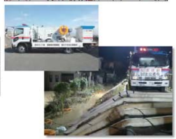
写真上：国土交通省が所有する排水ポンプ車 写真下：排水作業状況(H27.9)
