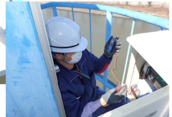
水位観測所のセンサーの交換(関東地方整備局)
