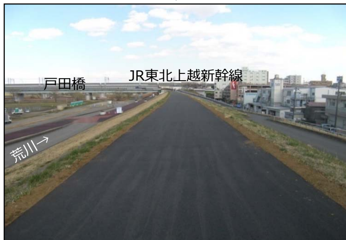
荒川右岸 板橋区舟渡地先(戸田橋上流)
