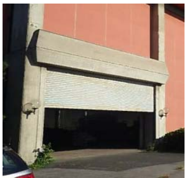
搬入ゲートの止水ゲート化
