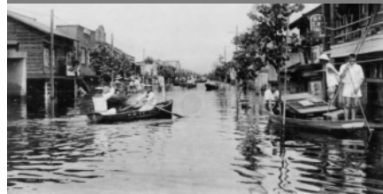
S13洪水時の土浦市内の様子
