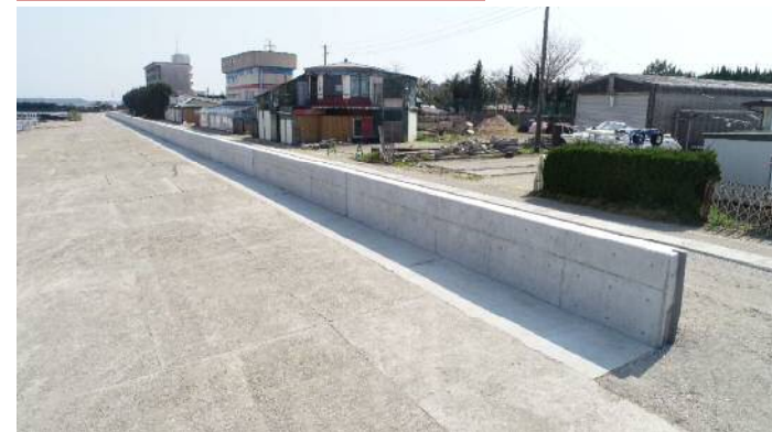
平成30年度の堤防整備 潮来市釜谷地先
