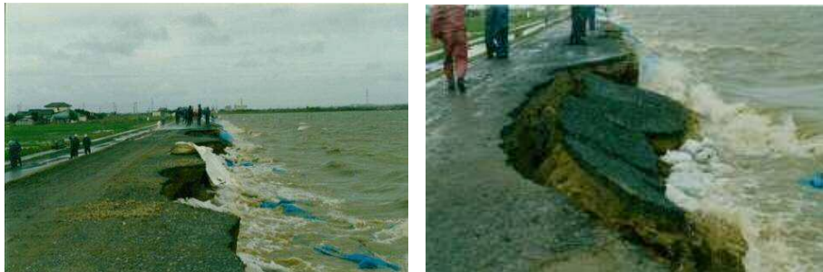
平成3年10月台風21号での被災状況（香取市一ノ分目新田地先）
