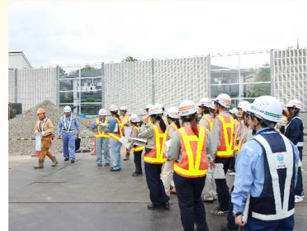
現場点検③
