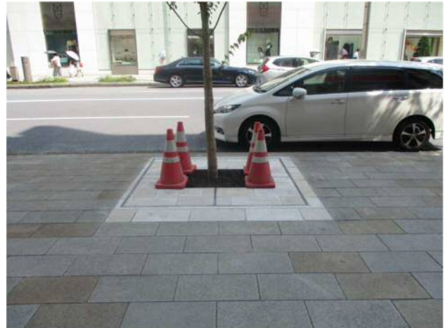
図-5 ツリーサークル設置状況
