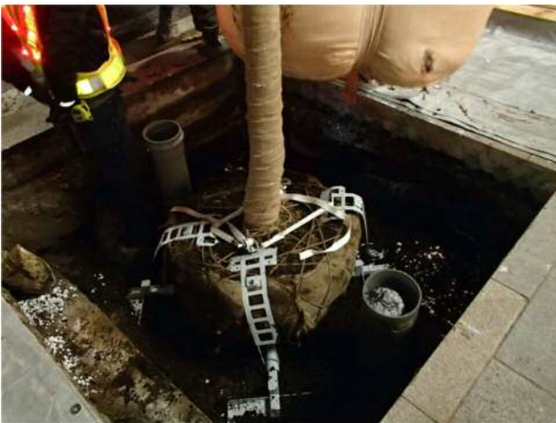
図-4 採用された地下支柱形状
