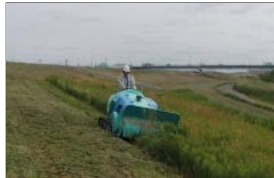
写真-1 従来のハンドガイドの施工状況
