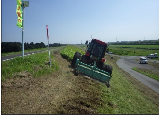
写真-4 法面 1 : 4 の試験施工状況
