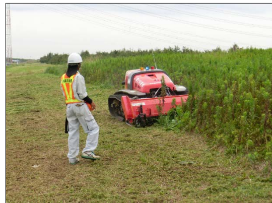
写真-2 法面1：7の試験施工状況
