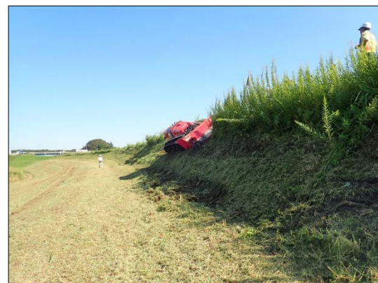
写真-3 法面1：1.9の試験施工状況
