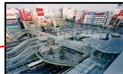
歩行者デッキ等の整備
