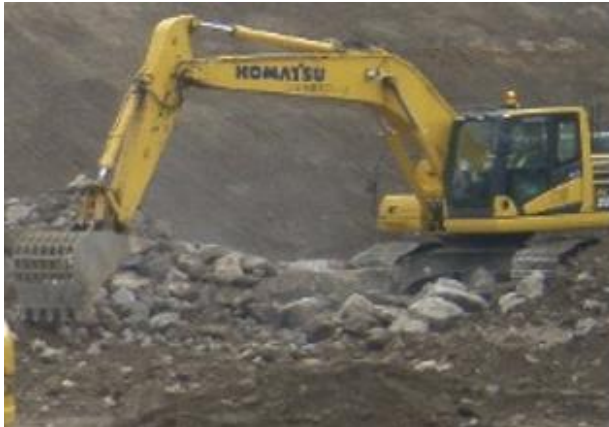
写真-3 支障となる転石・玉石の除去
