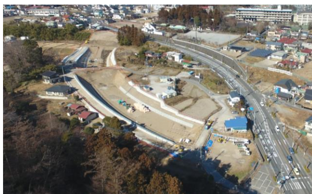
写真-1 3次元設計データを基に実施した ICT 土工 (渋川西バイパス入沢他改良その 1 工事)
