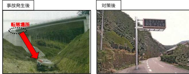
下りが連続する国道で速度超過により発生した死亡事故を受けて、危険箇所道路情報提供装置を設置。
