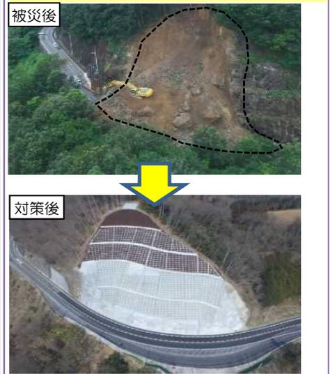
災害復旧事業の対象とならない風化・劣化による崖崩れで通行止めが発生したため、推進費により法面对策を実施。
