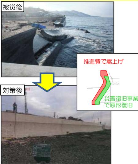
被災した護岸を災害復旧事業による原形復旧にあわせて、推進費により高上げを実施。
