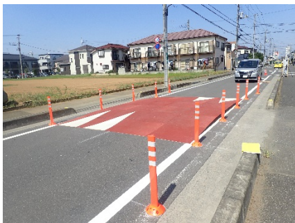
写真2 可搬型ハンプ設置状況
