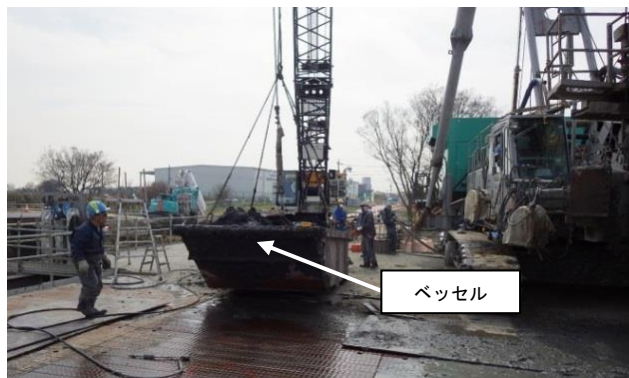
写真-4 既製杭の残土搬出状況
