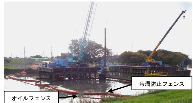
写真-5 オイルフェンス及び汚濁防止フェンス設置状況
