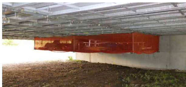
写真-10 仮設テントの保管状況
