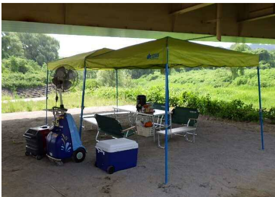
写真-9 出水期間中の仮設現場詰所
