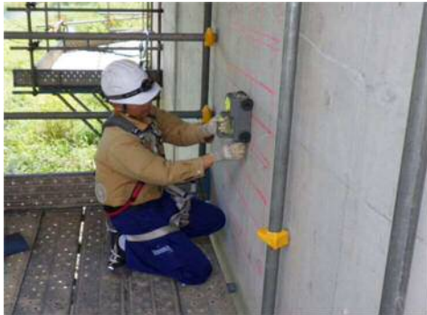
写真-5 鉄筋探査の実施
