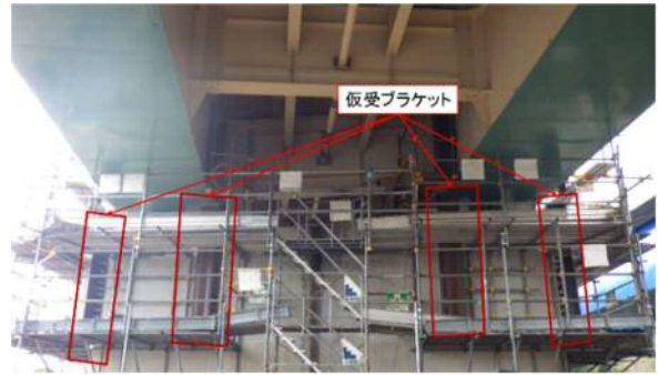
写真-2 仮受ブラケット設置状況
