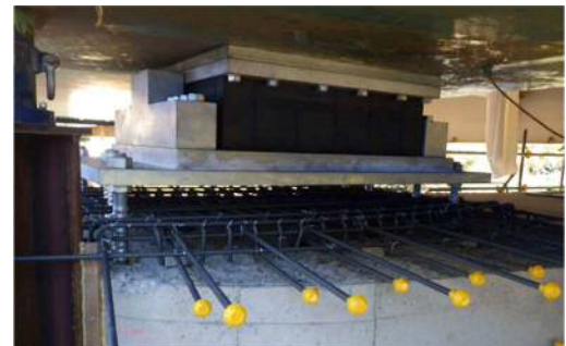
写真-4 免震ゴム支承設置状況
