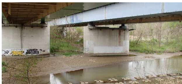
写真-1 現地状況
