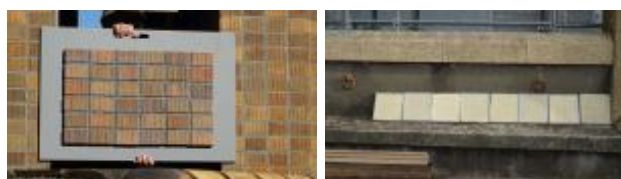
タイル色合わせ 洗出しサンプル 写真-3 外壁試験施工写真
