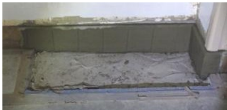
写真-7 幅木補修試験施工
