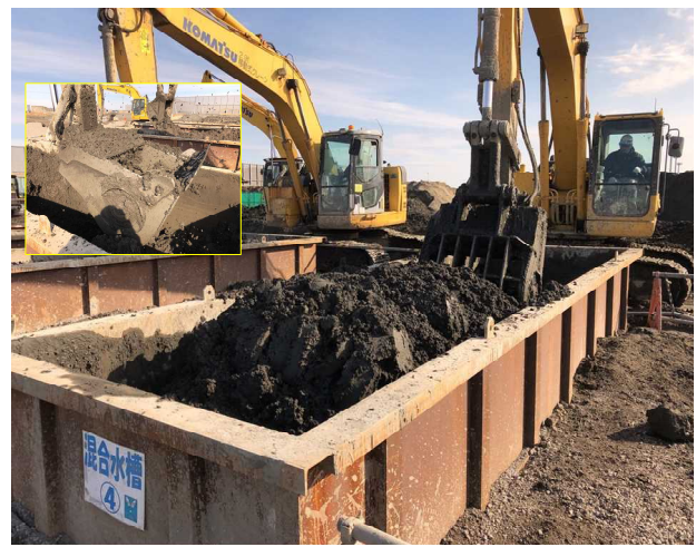
写真-3 鋼製水槽を使用したバックホウ混合工法
