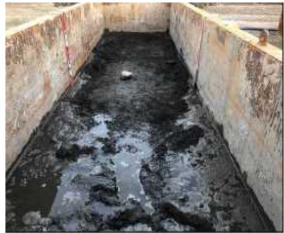
写真-4 水中投入状況
