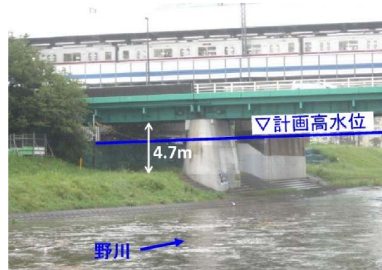
図-4 既設橋梁による堤防高の制約
