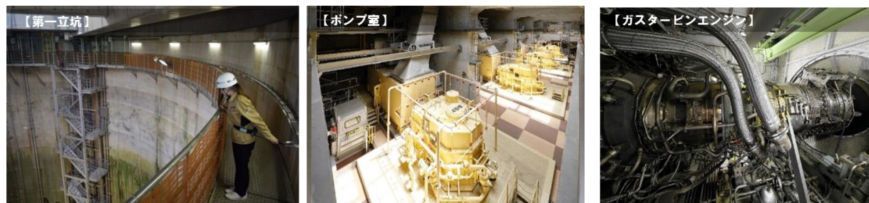
【写真－8】施設改修を行い公開可能となった施設
