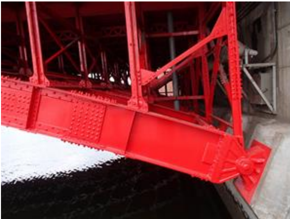
図-11 アーチリブ取替完了
