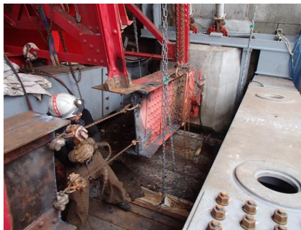
図-6 既設アーチリブ撤去状況
