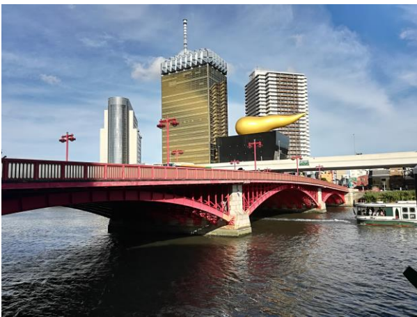
図-1 吾妻橋全景(隅田川下流右岸から望む)
