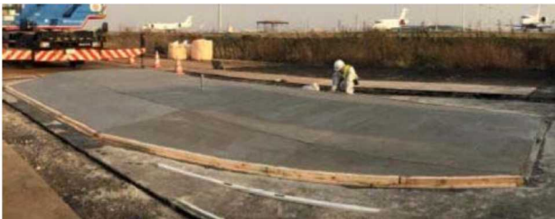
写真 - 5 モックアップ全景
