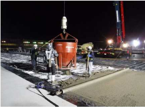
写真 - 4 CLSM打設状況
