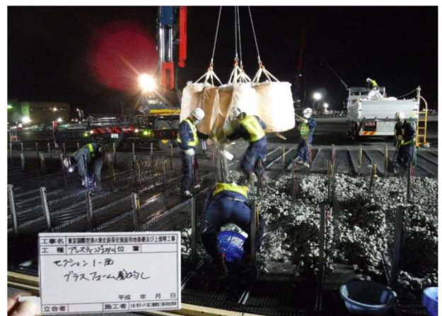
写真-3 フォームガラス投入状況
