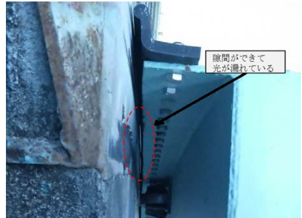
写真-4.5 4号ゲート右岸側 上部 (計測ポイント 18 付近)
