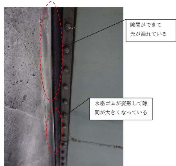
写真-4.1 1号ゲート左岸側
