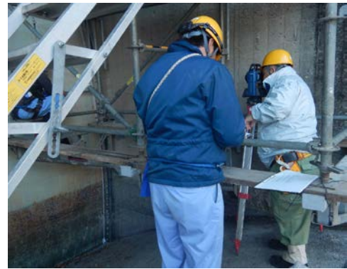
写真-3.4 戸当りの計測状況
