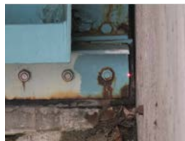
写真-3.2 扉体の計測状況 （計測ポイント 0）
