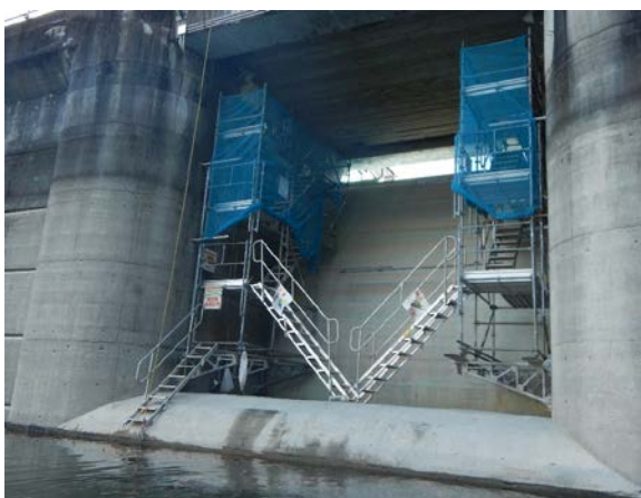
写真-3.3 戸当り計測用仮設足場
