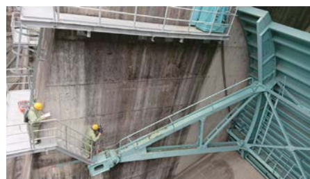
写真-3.2 扉体の計測状況
