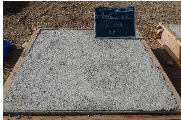
写真3 硬化後のコンクリート
