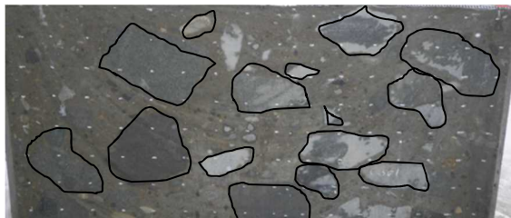
写真1 供試体切断面の状況
