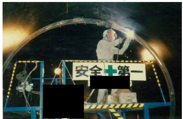
写真三 現場溶接時の養生状況①
