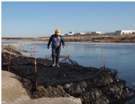
袋詰玉石工(4t)の袋を設置
