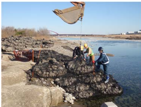
小規模な袋詰玉石工(1t)の設置
