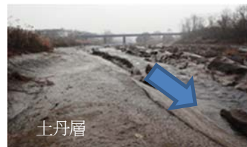
図-1 土丹層の露出状況
