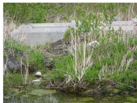
図-15 袋詰玉石工と植生状況
