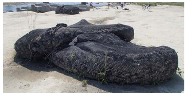
図-9 袋詰玉石工の変異状況
