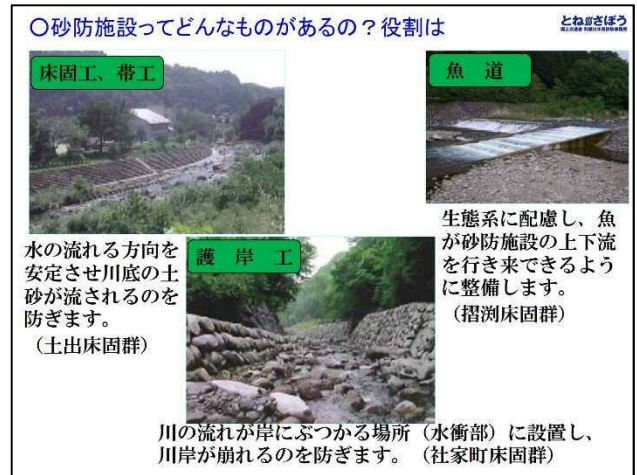
図-4 砂防施設の種類の役割
