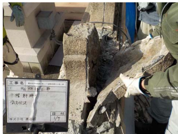
写真-4 装飾部の採取状況
