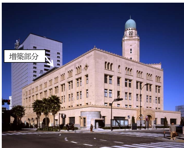
写真-2 東南側面（平成の大改修時の完成写真 写真左手にわずかに見えるのが増築部分）
