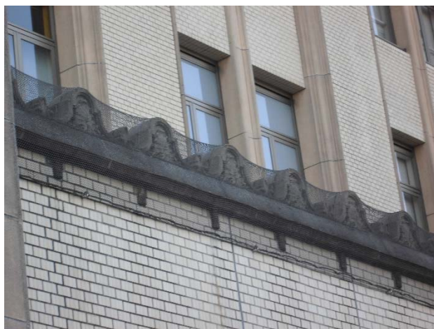
写真-3 ネットによる落下措置実施状況
