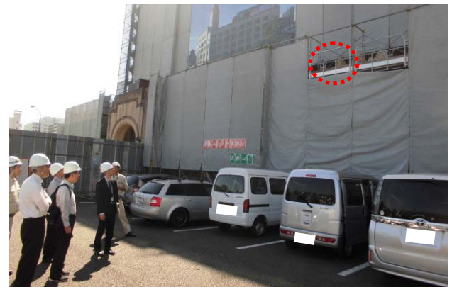
写真-8 クレイモデルを軒上に仮置きしての確認
