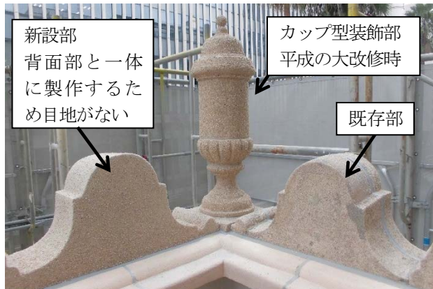
写真-12 新設部と存置部の比較
