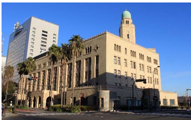
写真-13 今回外壁改修後の状況
