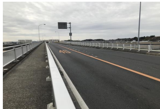
図－7 施工1年後の舗装状況
