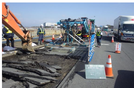
図-4 IH式舗装撤去工法施工状況
