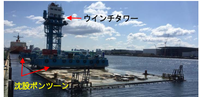
写真-7 沈埋函二次艀装（浮遊打設場所）
