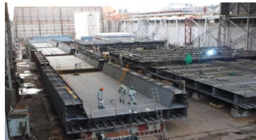
写真-3 鋼殻ブロック製作
