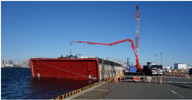
写真-6 浮遊打設状況
