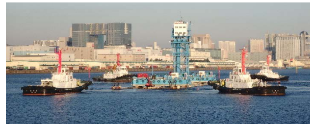
写真-8 沈埋函曳航（沈設前）
