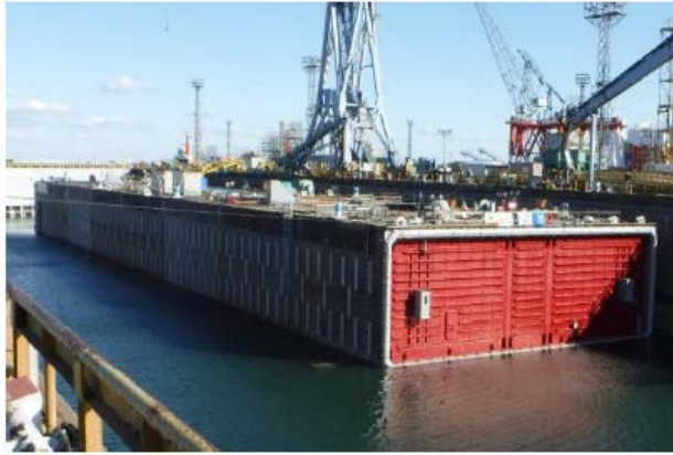
写真-5 鋼殻製作（大組立）完了時（ドック出渠前）
