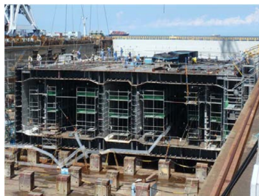
写真-4 大組立状況 (ドック内)
