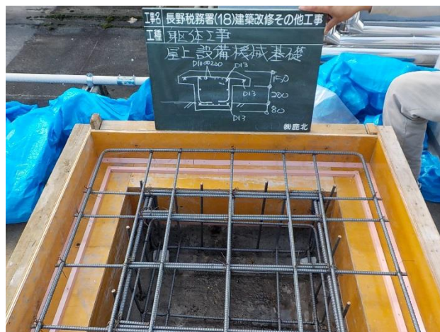
写真-1 従来の黒板を使用した工事写真
