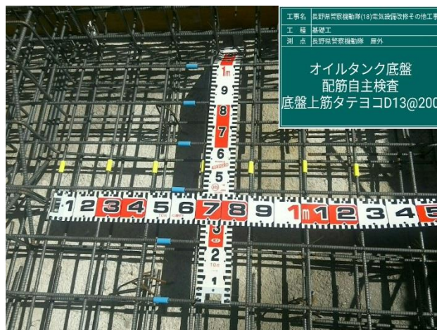
写真-2 電子小黒板を使用した工事写真
