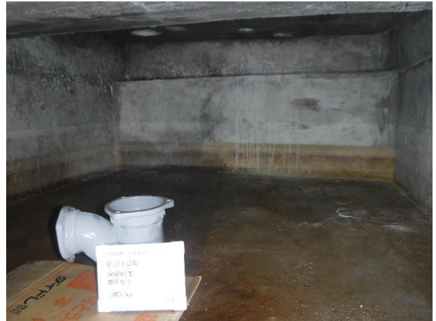
写真4 光が反射し、文字が見えづらい黒板 (改修工事における建物内地下ピットの状況)
