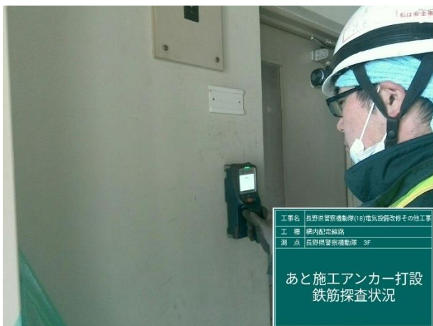
写真3 手ぶれが無い工事写真
