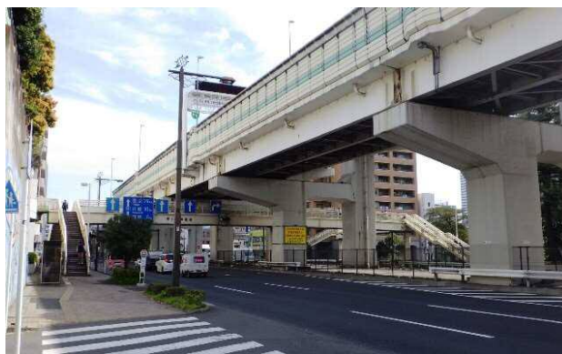
写真1 幸ヶ谷歩道橋
