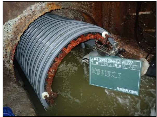
写真-2 製管状況
