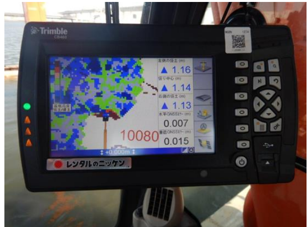
写真-3 オペレーターの確認モニター
