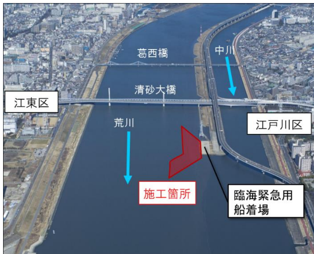
図-1 施工箇所俯瞰
