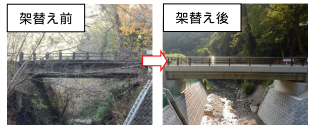
図-3 八幡橋(上流から撮影)
