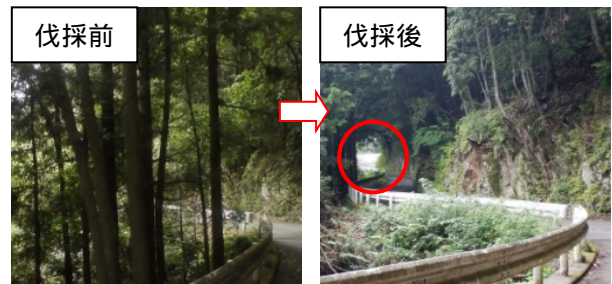
図-2 樹木伐採による迂回路の見通し改善
