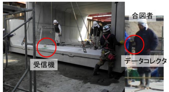
図-9 カルバート据付状況
