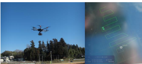
図-6 UAV 測量状況
