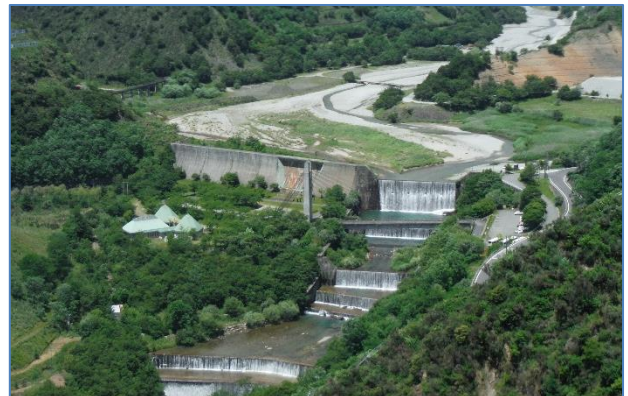
写真-1 足尾砂防堰堤
