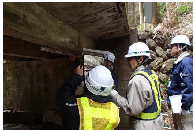
写真4 現場班の作業状況
