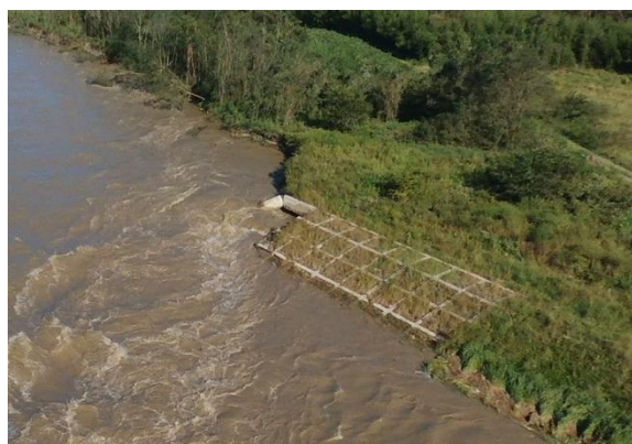
図-1 ドローンによる出水後の現場確認
