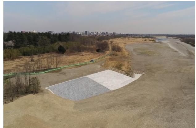
図-4 護岸工事施工状況
