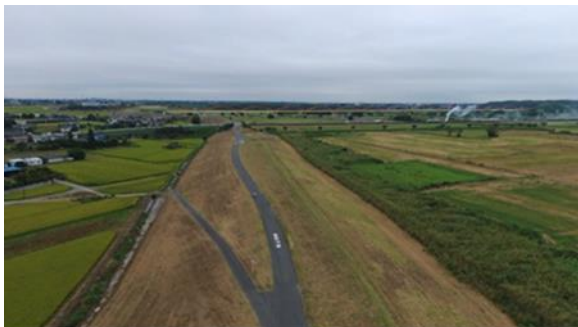
図-3 堤防の除草状況
