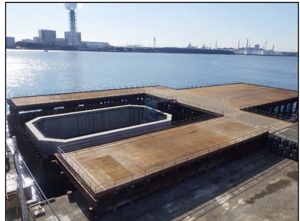
写真-3 MP4 橋脚基礎施工後
