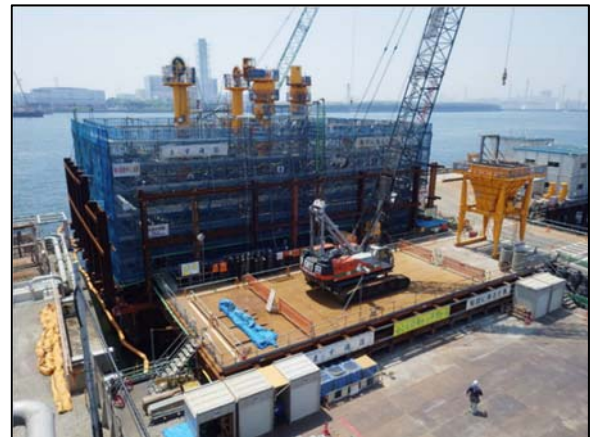
写真-1 ニューマチックケーソン基礎構築状況
