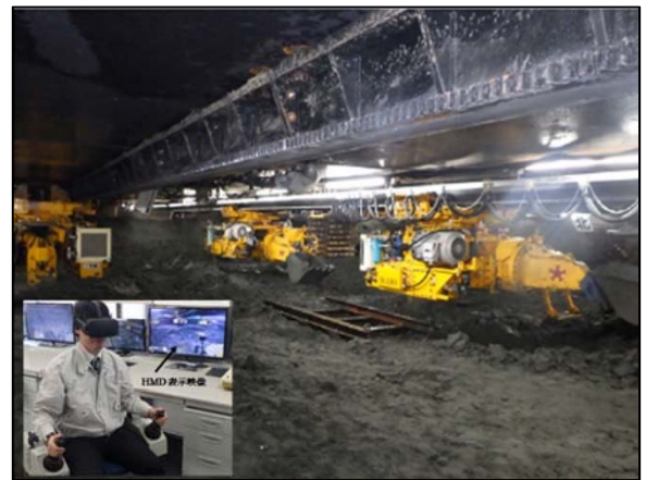
写真-2 ケーソン作業室内掘削状況及びヘッドマウントディスプレイ装着写真
