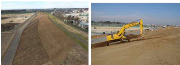
写真-1 工事完成状況 写真-2 ICT 建機による施工状況
