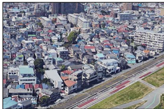
写真2 沿川における木造密集地域【墨田区】
