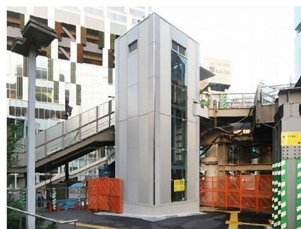
図-2 エレベーター設備（渋谷駅東口歩道橋）
