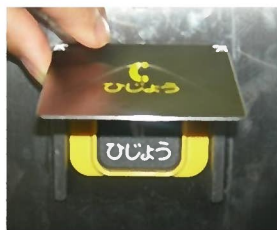
図-8 非常通報押し釦カバー
