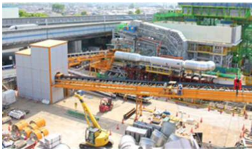
写真-1 東名 JCT の現場写真
