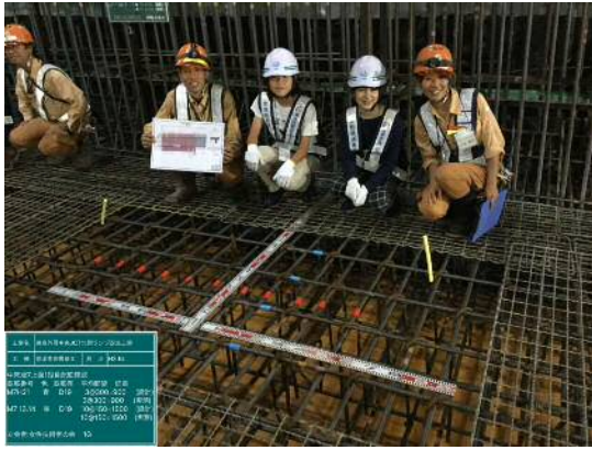
写真-8 電子小黒板を使用した鉄筋検査の様子
