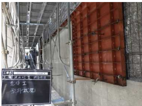
写真-5 充填工法
