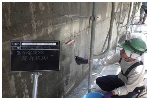
写真-6 含浸材塗布
