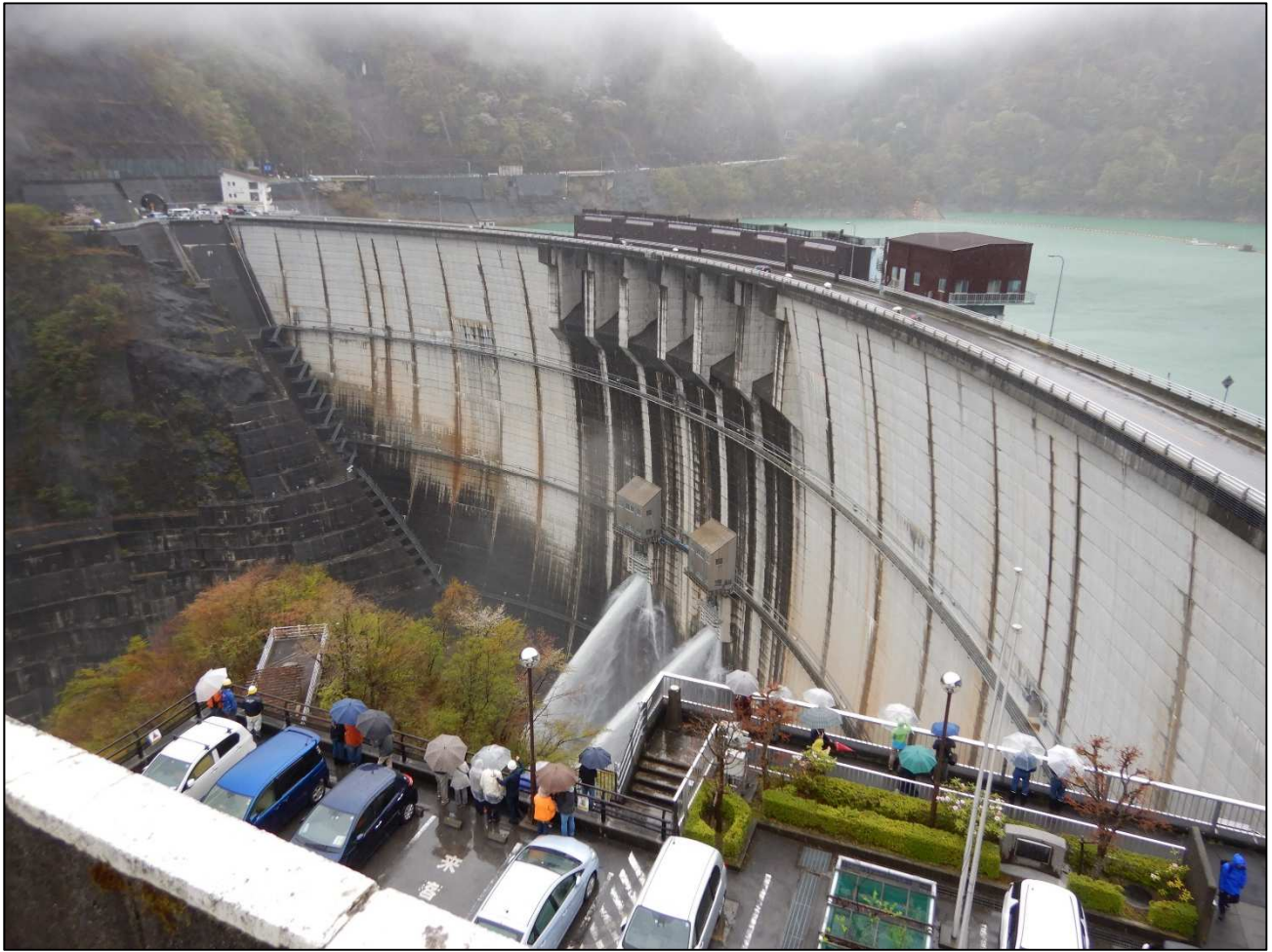
常用放流設備(コンジットゲート)からの点検放流
