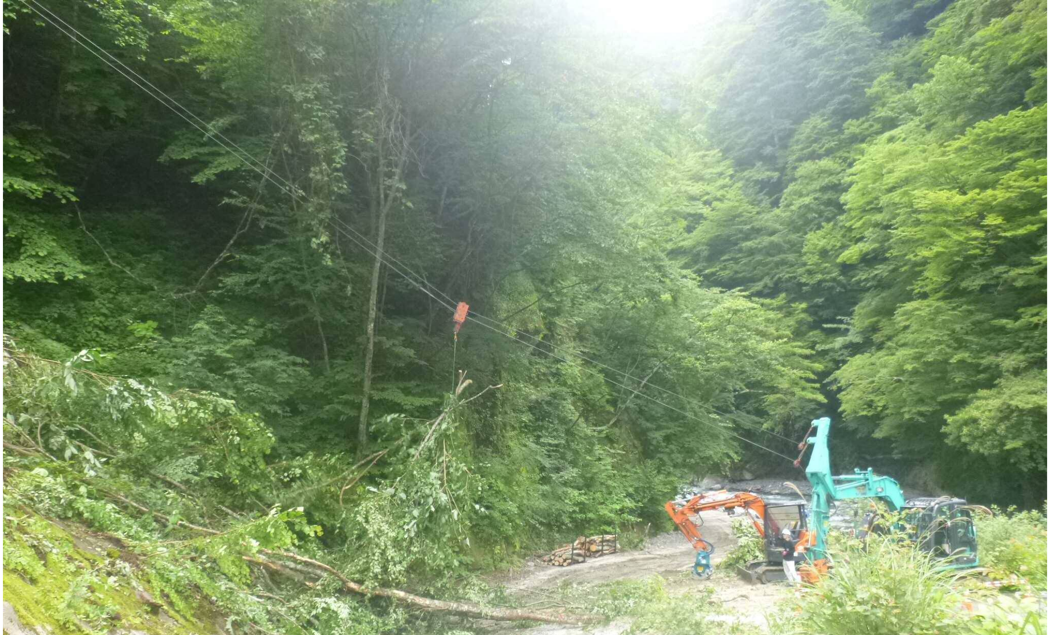
作品タイトル：伐採木集積 撮影者コメント：簡易索道って便利 撮影日・撮影場所：2018/7/11 山梨県北杜市白州町横手地先 撮影者会社名：丹澤建設工業(株) 撮影者：遠藤 栄一
