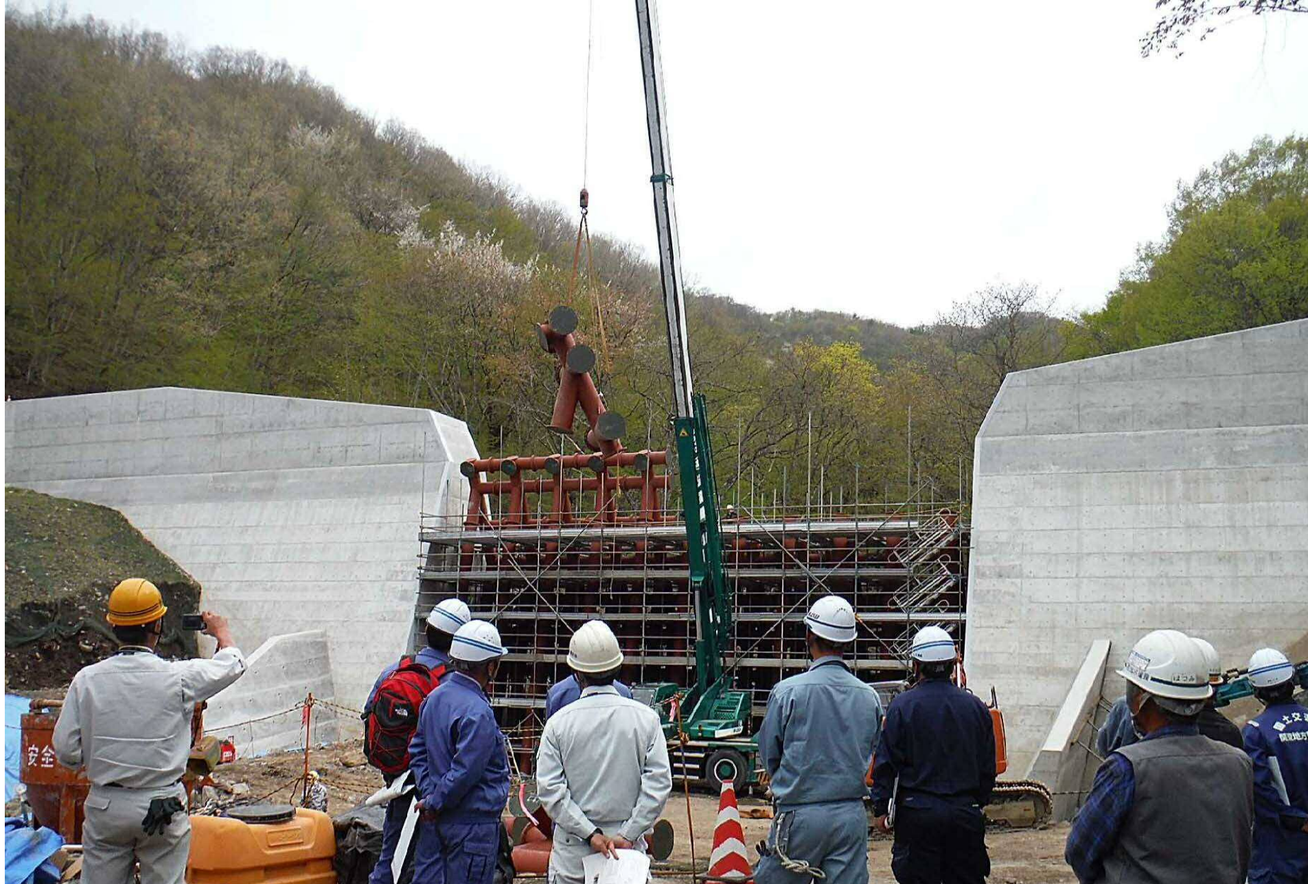
作品タイトル：現場見学会 撮影者コメント：鋼製スリット堰堤(161t)施工中の現場見学会開催状況 撮影日・撮影場所：2018/4/27 栃木県日光市上栗山地先 撮影者会社名：那須土木(株) 撮影者：阿久津 隼人
