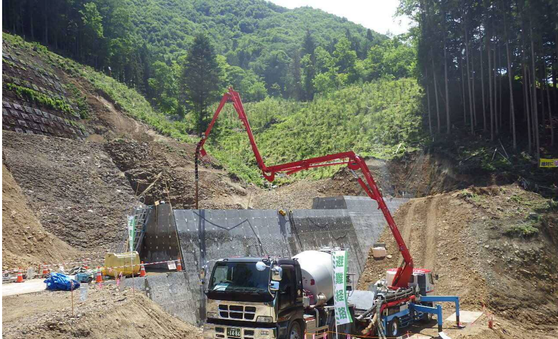
作品タイトル：コンクリート打設 撮影者コメント：コンクリートポンプ車でのコンクリート打設状況 撮影日・撮影場所：2018/6/2 コンクリート堰堤本体工 撮影者会社名：池下工業(株) 撮影者：千木良 幸成
