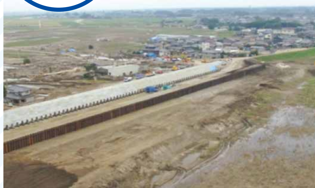
【施工前】2016年1月12日
