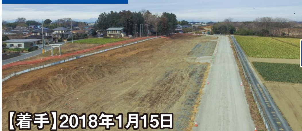
土堤部・施工前
