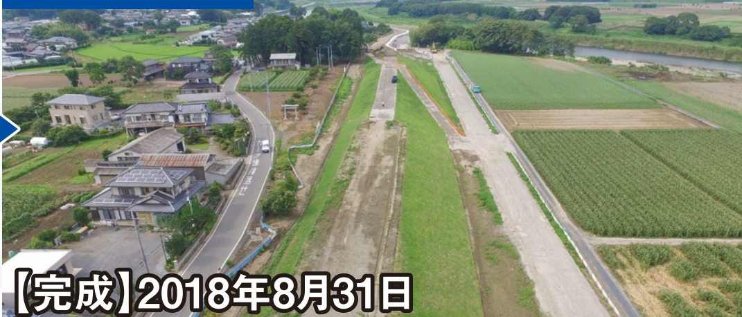
土堤部・完成
