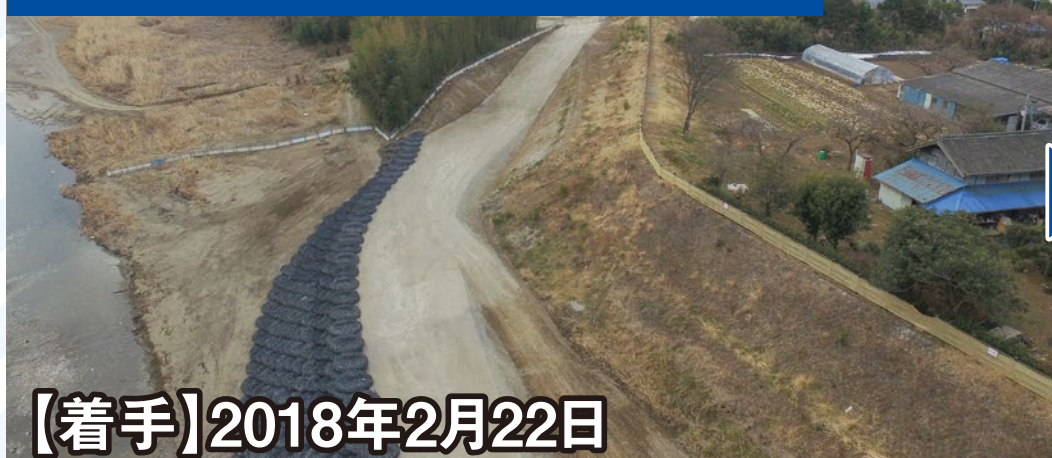
ブロック積護岸造成部・施工前
