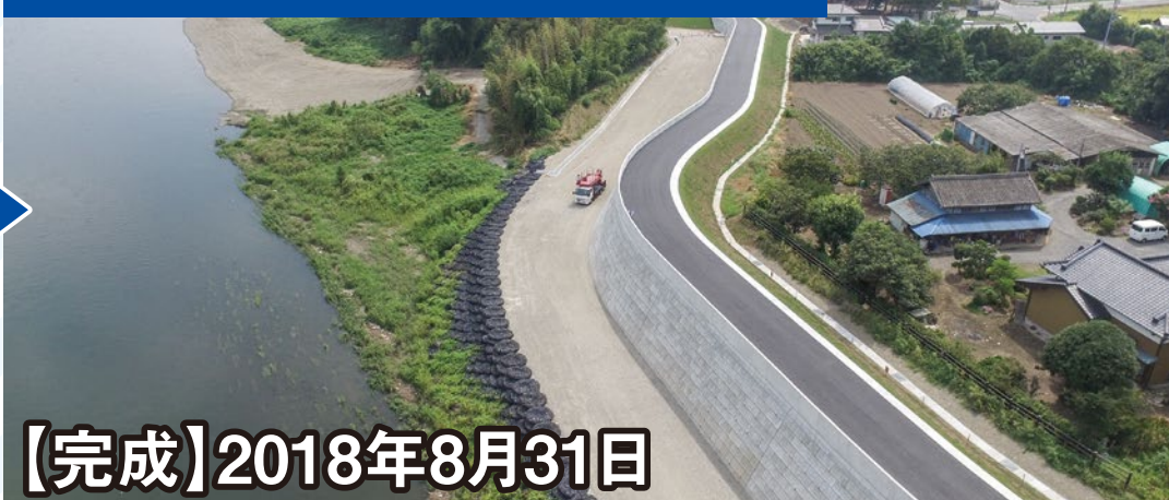
ブロック積護岸造成部・完成
