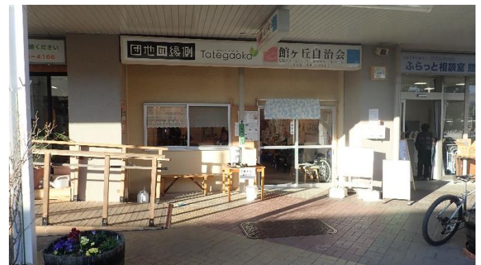
【写真2】 自治会が管理・運営する団地の縁側
