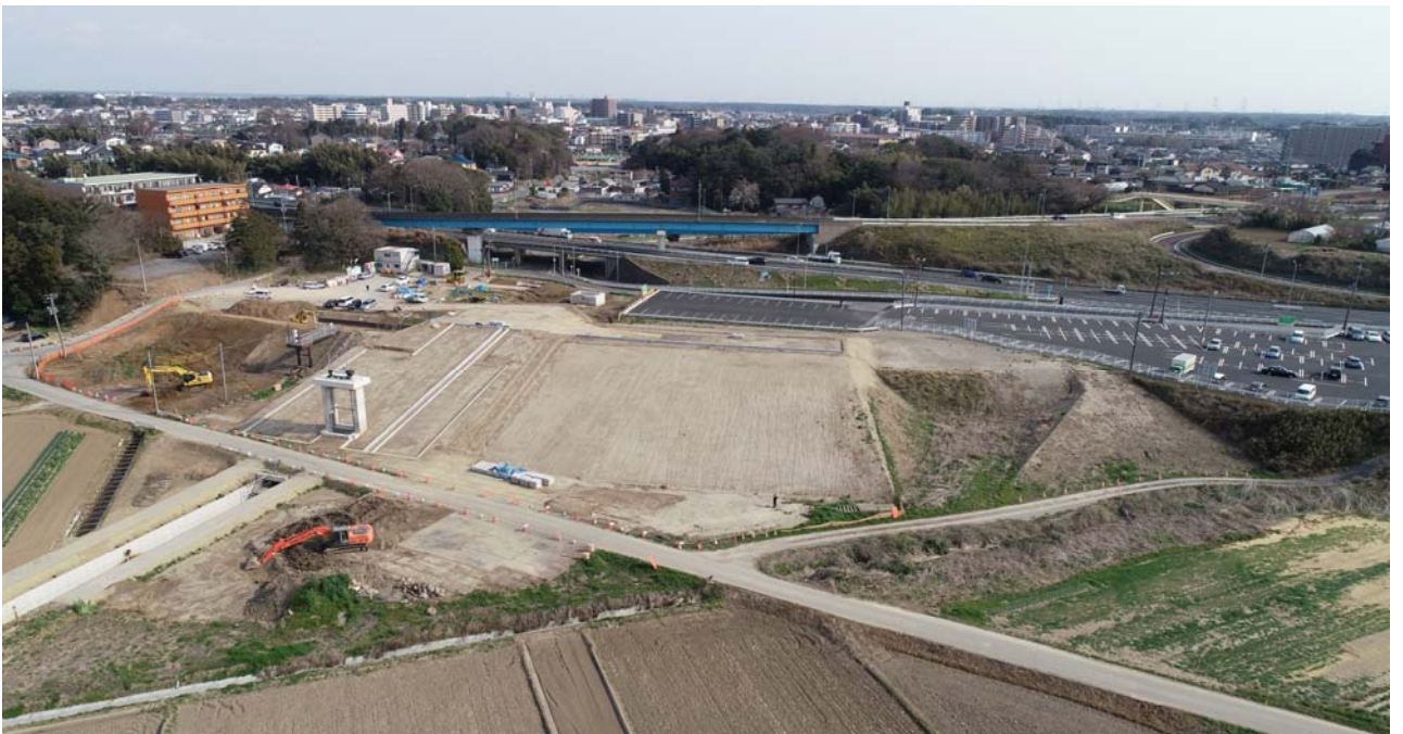
UAV撮影 (川表、上流から下流を望む)
