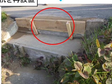
板と杭を再設置
