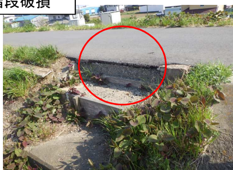
階段破損
